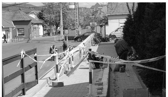
Munka közben: a művelődési ház bejáratának felújítása
